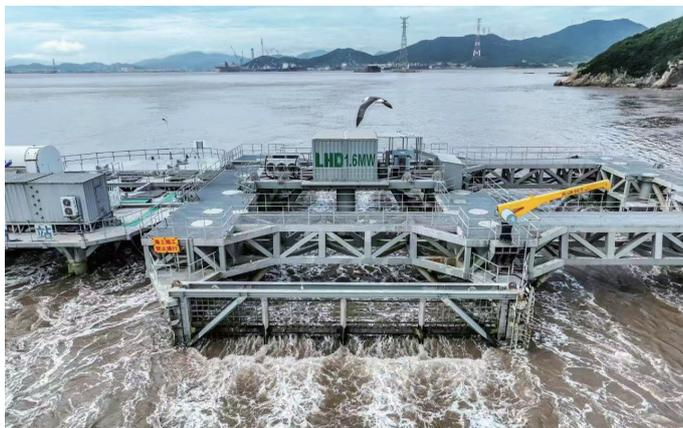
世界最大单机 LHD 第四代 1.6 兆瓦潮流能机组“奋进号”正在发电并网运行
